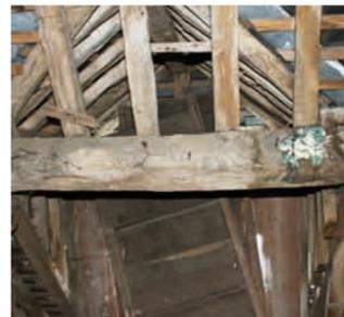
Dès janvier, des travaux seront engagés sur le presbytère de Plélan pour sécuriser sa structure. Il s'agit de démolir les plafonds de la façade ouest pour découvrir la souche des cheminées et la charpente, mise à mal par des infiltrations d'eau. Pendant la durée de ces travaux, le parking du presbytère sera en partie occupé par du matériel de chantier.
